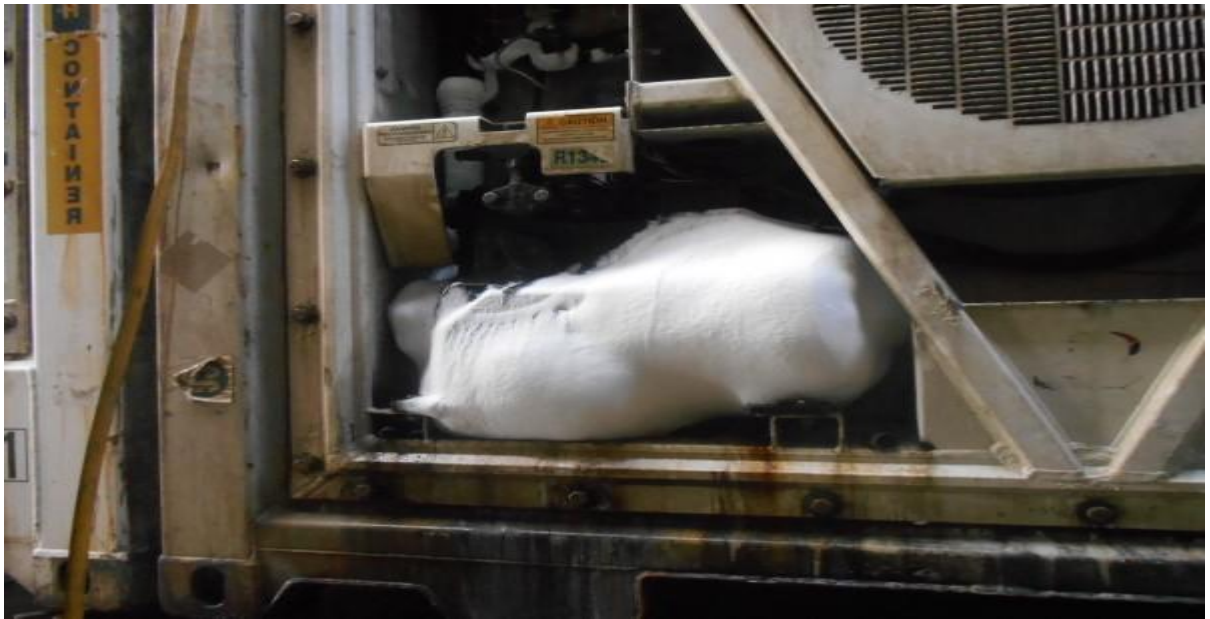
Рис. 5.8 – Намерзання на всмоктувальній лінії та компресорі
