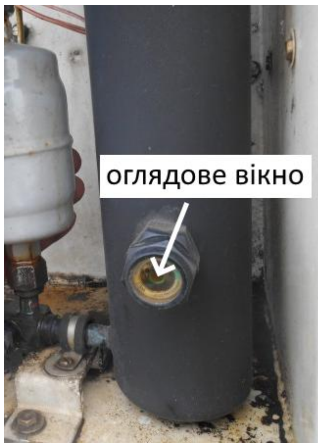
Рис. 5.11 – Ресивер з фільтром
