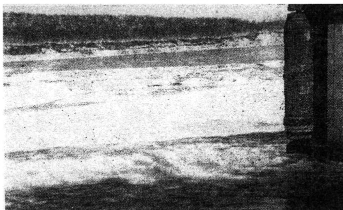
Задержание льда с помощью пневмосистемы, проложенной по дну акватории перед торцом дока
