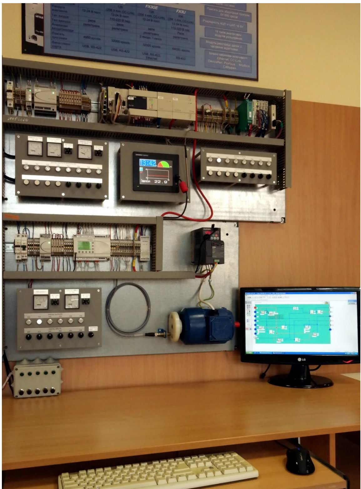
Рис. 1 - Навчально-лабораторний стенд (загальний вигляд)
