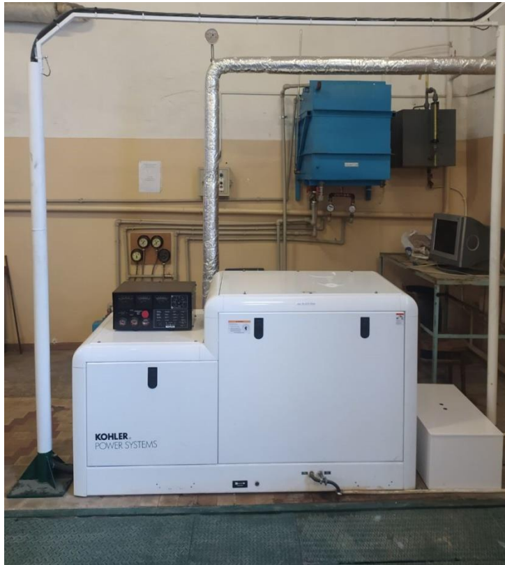
Рисунок 1 – Зовнішній вигляд АДГ «John Deere 4045TFM75» та елементів системи охолодження.
