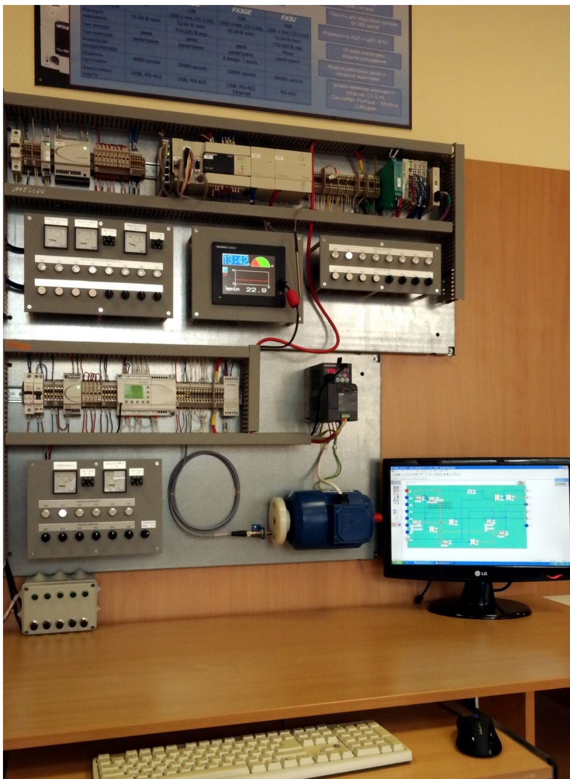
Рис. 1 - Навчально-лабораторний стенд (загальний вигляд)
